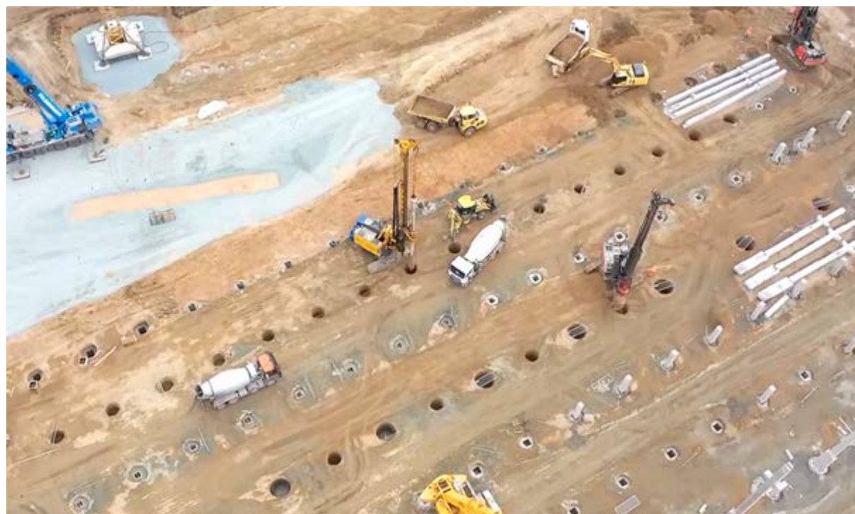
Pfahlgründung – Halle Panattoni Park Most, CTP Brno Halle G2 Hitachi Energy, CTP ZET10
