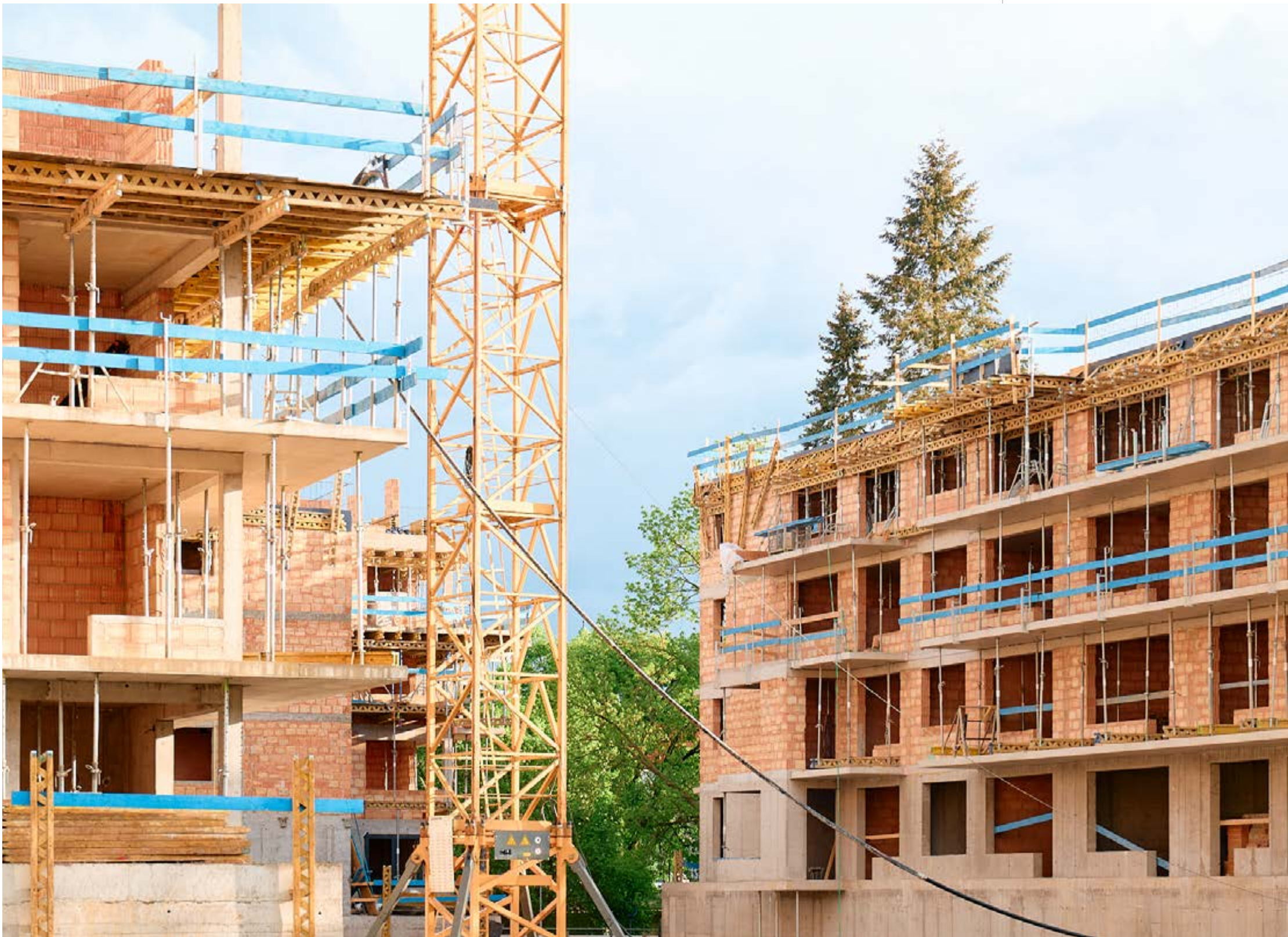
Rezidence Smetanovy sady, Vyškov. Na místě původní prádelny Chřišťof vyrostly v první etapě výstavby celkem tři bytové domy se 126 byty, nabízející moderní koncept městského bydlení založený na kvalitních materiálech a chytrých technických řešeních.
