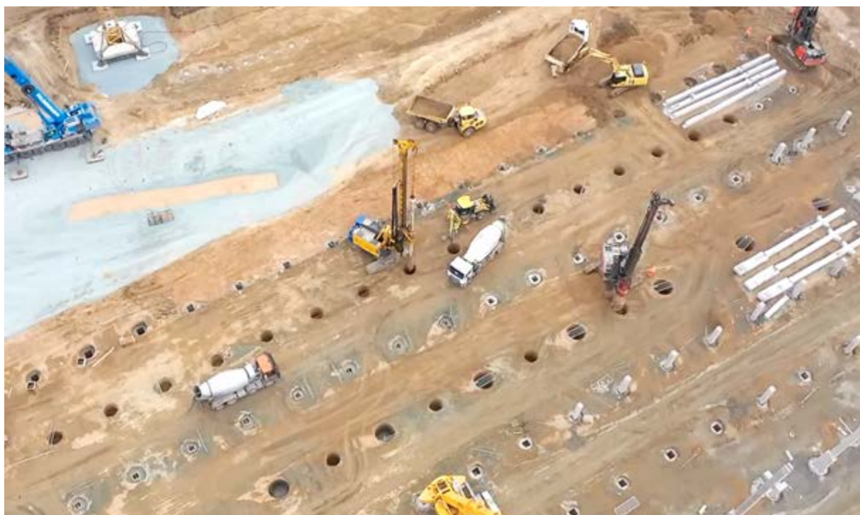
Pilotové založení – hala Panattoni Park Most, CTP Brno hala G2 Hitachi Energy, CTP ZET10
