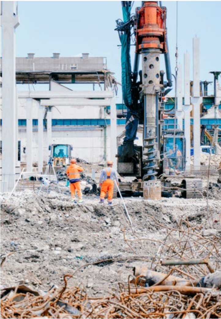
Brno Královopolská. Budoucí podnik Thermo Fisher Scientific bude sloužit pro výrobu velmi přesných laboratorních přístrojů, což zvyšuje technické nároky stavby, zejména zajištění proti otřesům. Základem stavby se stalo 422 pilot s patkami pro kalichy.
