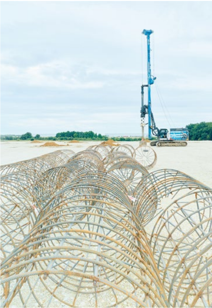
CT Park Prague Nord. Již několikátá zakázka v řadě v průmyslové zóně za Prahou směrem na Kralupy, tentokrát na jejím základě roste skladovací hala pro síť drogerií Rossmann. Třetina haly musela být pažena ocelovými výpažnicemi, celkem bylo použito na 300 ks pilot.
