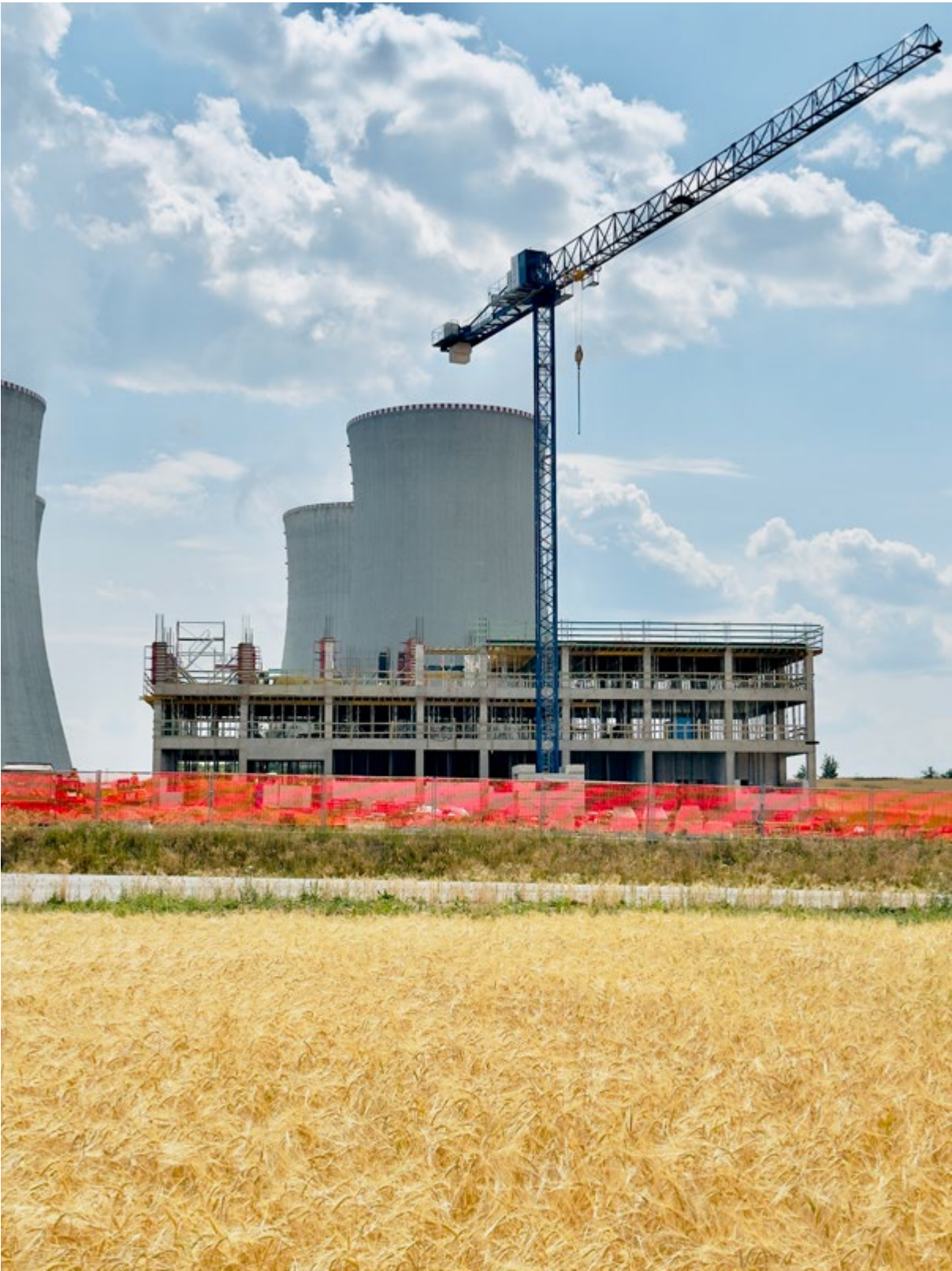
Zázemí pro investora – administrativní prostory a parkoviště, Jaderná elektrárna Dukovany II, a. s. Budované administrativní prostory nabízejí kanceláře, zasedací místnosti, sociální zázemí, bufet, přilehlé parkoviště a výhled na zátiší čtyř chladicích věží. Právě bezprostřední blízkost Jaderné elektrárny Dukovany přináší zvýšené nároky na bezpečnostní opatření při výstavbě.
