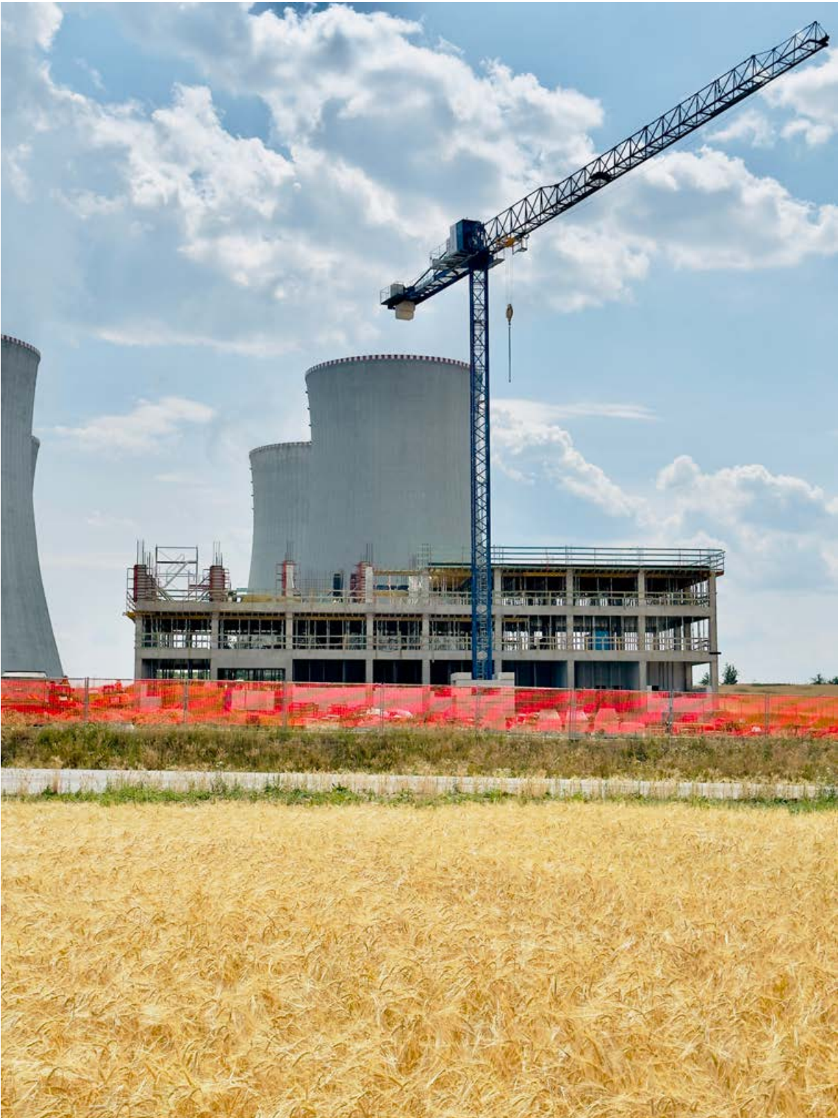
Infrastruktur für den Investor – Verwaltungsräume und Parkplätze, Kernkraftwerk Dukovany II, a. s. Die entstehenden Verwaltungsräume bieten Büros, Besprechungsräume, Sozialräume, eine Kantine, angrenzende Parkplätze und eine Kulisse von vier Kühltürmen. Die unmittelbare Nähe des Kernkraftwerks Dukovany bringt erhöhte Anforderungen an Sicherheitsmaßnahmen während der Bauarbeiten mit sich.
