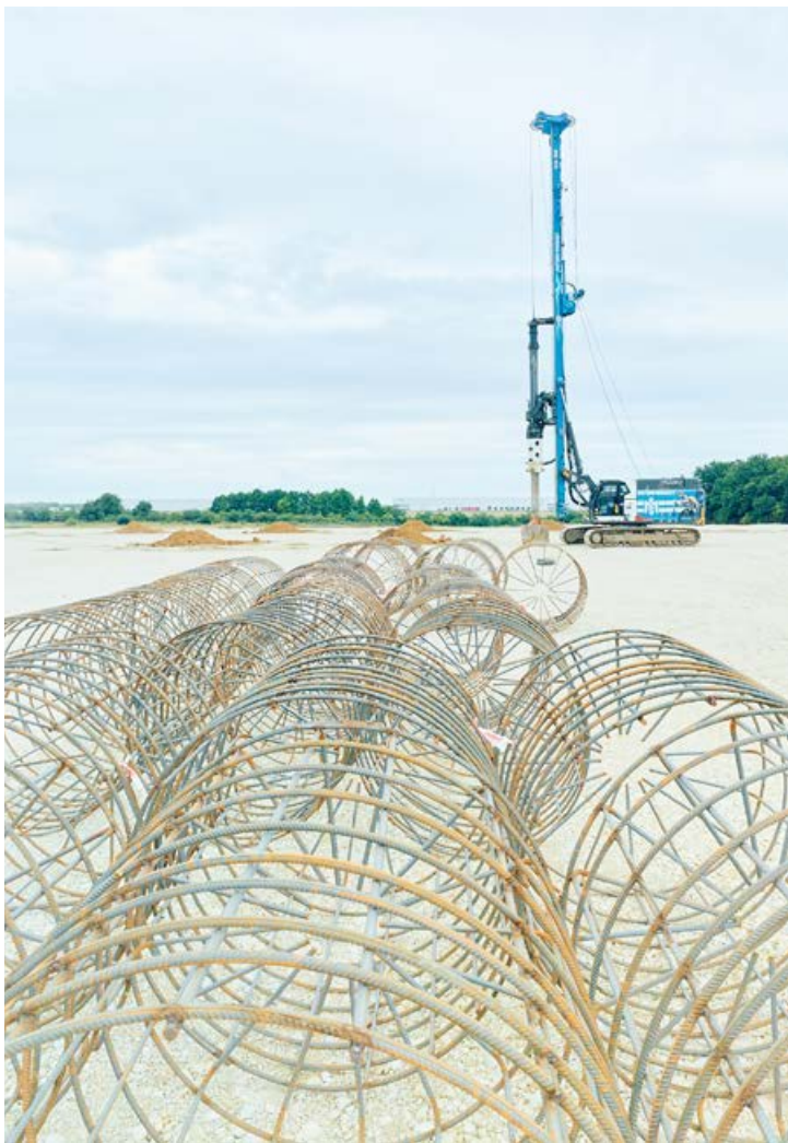
CT Park Prague Nord. Bereits der nächste Auftrag in Folge in der Industriezone hinter Prag in Richtung Kralupy – diesmal entsteht hier eine Lagerhalle für die Drogeriekette Rossmann. Ein Drittel der Halle musste mit Stahlspundbohlen gesichert werden, insgesamt wurden etwa 300 Pfähle eingesetzt.
