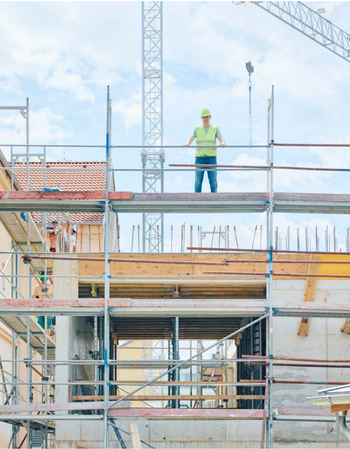
Wohnhaus Bränn, Staňkova-Straße. PAMSTAV errichtete hier Stahlbetonkonstruktionen und Fertigtreppe für das entstehende Gebäude mit zwei Untergeschossen für Tiefgaragen und acht Obergeschossen mit Wohnungen.
