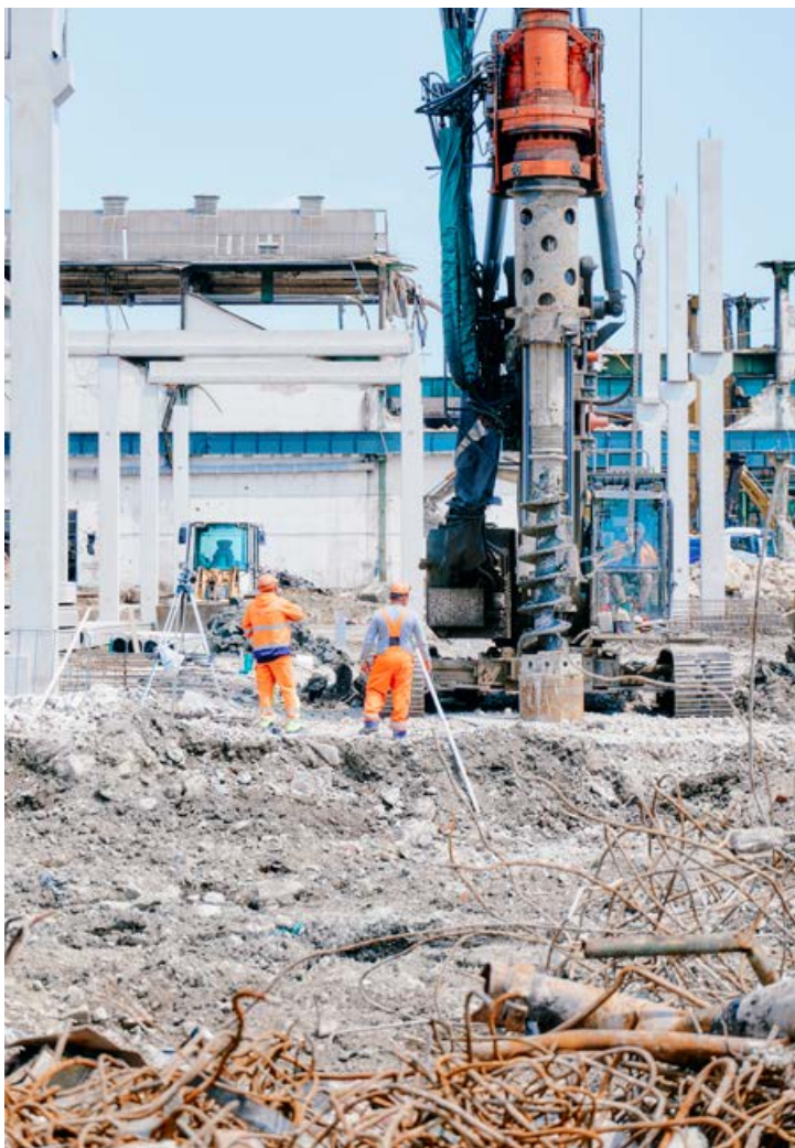
Brünn Královopolská. Der künftige Betrieb Thermo Fisher Scientific wird der Herstellung hochpräziser Laborgeräte dienen, was die technischen Anforderungen an den Bau erhöht, insbesondere hinsichtlich der Erschütterungssicherheit. Die Grundlage des Baus bilden 422 Pfähle mit Sockeln für Kalotten.
