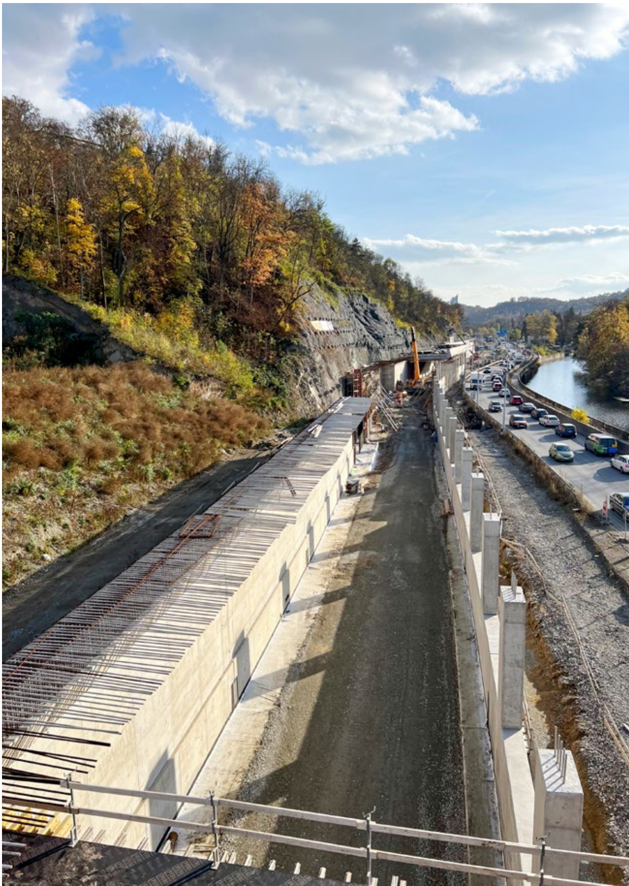
Velký městský okruh Brno má vyhotovený nový 350 m dlouhý úsek vedoucí z Králova Pole směrem k výstavišti. Železobetonové konstrukce pro něj dodal Winning PS Pamstav. Dvouproudová galerie s jednou sloupovou stěnou o sedmi metrech výšky je tvořena z 20 dilatačních celků. Výstavba trvala rok a půl.
