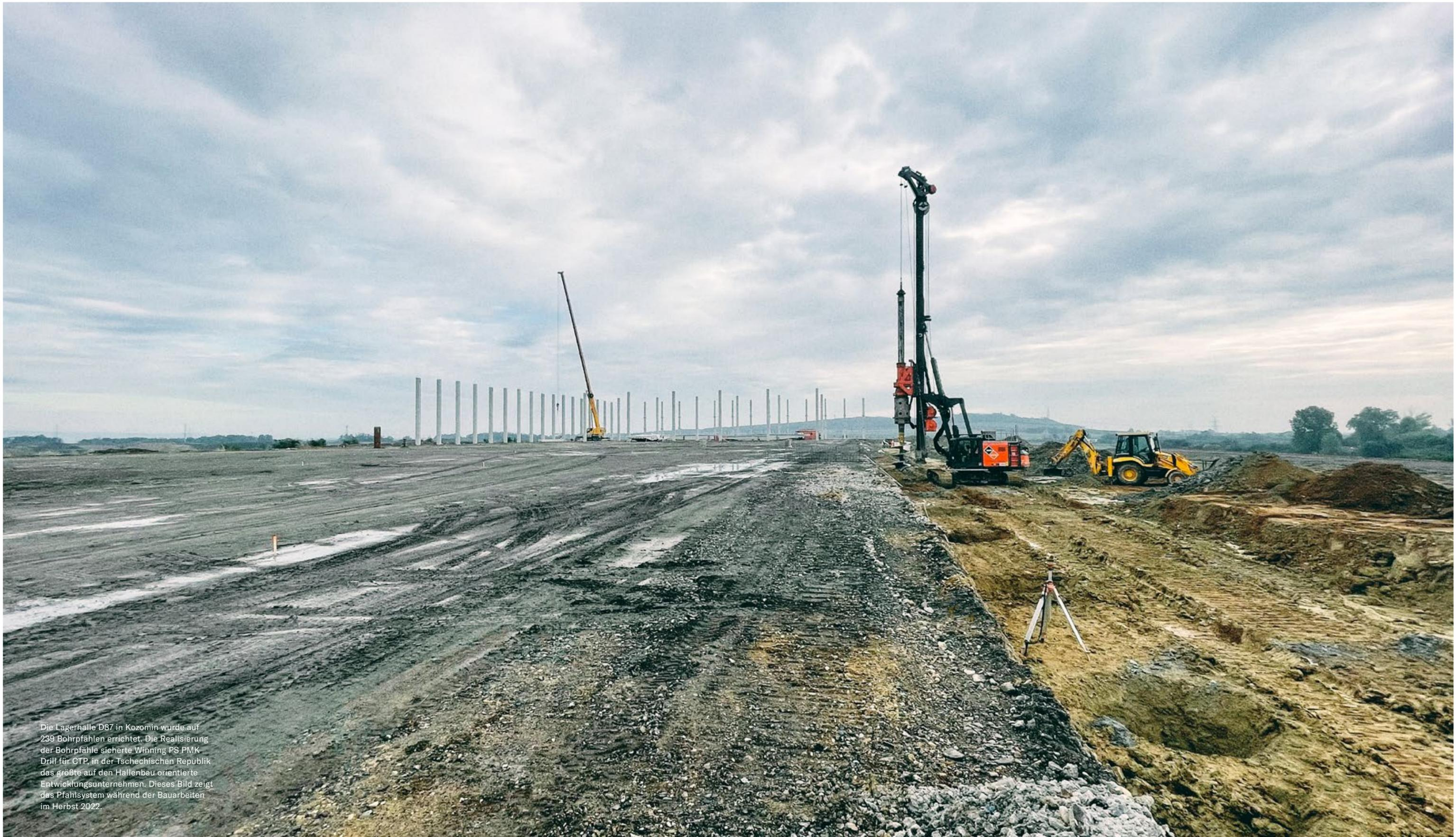
Die Lagerhalle D87 in Kozomin wurde auf 239 Bohrpfähle errichtet. Die Realisierung der Bohrpfähle sicherte Winning PS PMK Drill für OTP, in der Tschechischen Republik das größte auf den Hallenbau orientierte Entwicklungsunternehmen. Dieses Bild zeigt das Pfahlsystem während der Bauarbeiten im Herbst 2022.
