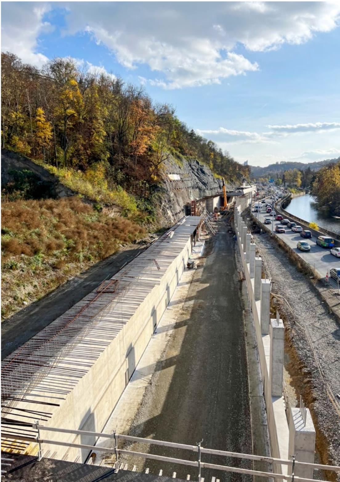
Der Große Stadtring von Brünn hat einen neuen 350 m langen Abschnitt, der vom Královo Pole zum Messegelände führt. Die Stahlbetonkonstruktionen dafür wurden von Winning PS Pamstav geliefert. Die zweispurige Galerie mit einer sieben Meter hohen Säulenwand setzt sich aus 20 Erweiterungseinheiten zusammen. Der Bau dauerte eineinhalb Jahre.
