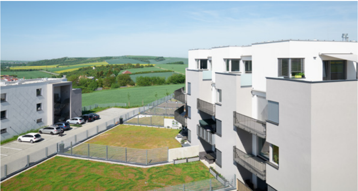
Rodinné domy v Padochově v průběhu výstavby (nahore). Houses in Padochov during construction (top).
